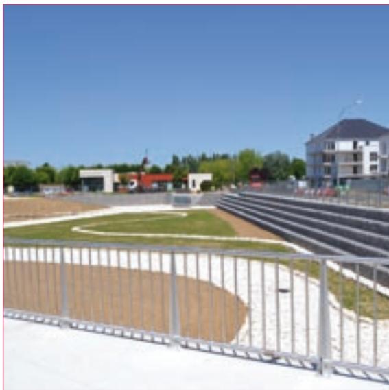
**Bassin d'orage de la place des Fêtes.** Le gros œuvre étant achevé, le bassin de rétention des eaux pluviales fait maintenant l'objet d'un aménagement paysager. Son volume de stockage atteint 5 500 m<sup>3</sup>. Nous reviendrons largement sur cette réalisation lorsque le chantier sera terminé (début juillet si la météo est clémente).
