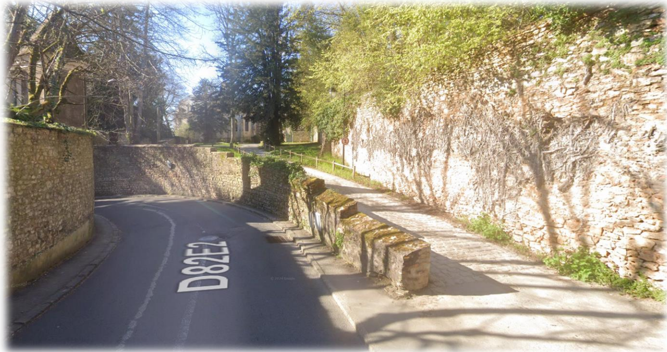
Figure 82 : Prise de vue de l’accès à l’Eglise Saint-Pierre et Saint-Paul via la Côte Sainte-Gemme (Source : Street view Google – Mars 2024)
